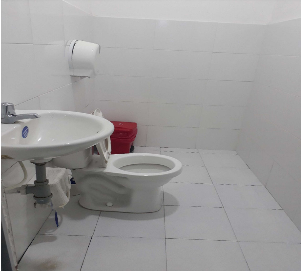
Recipiente de residuos peligrosos en cada baño
